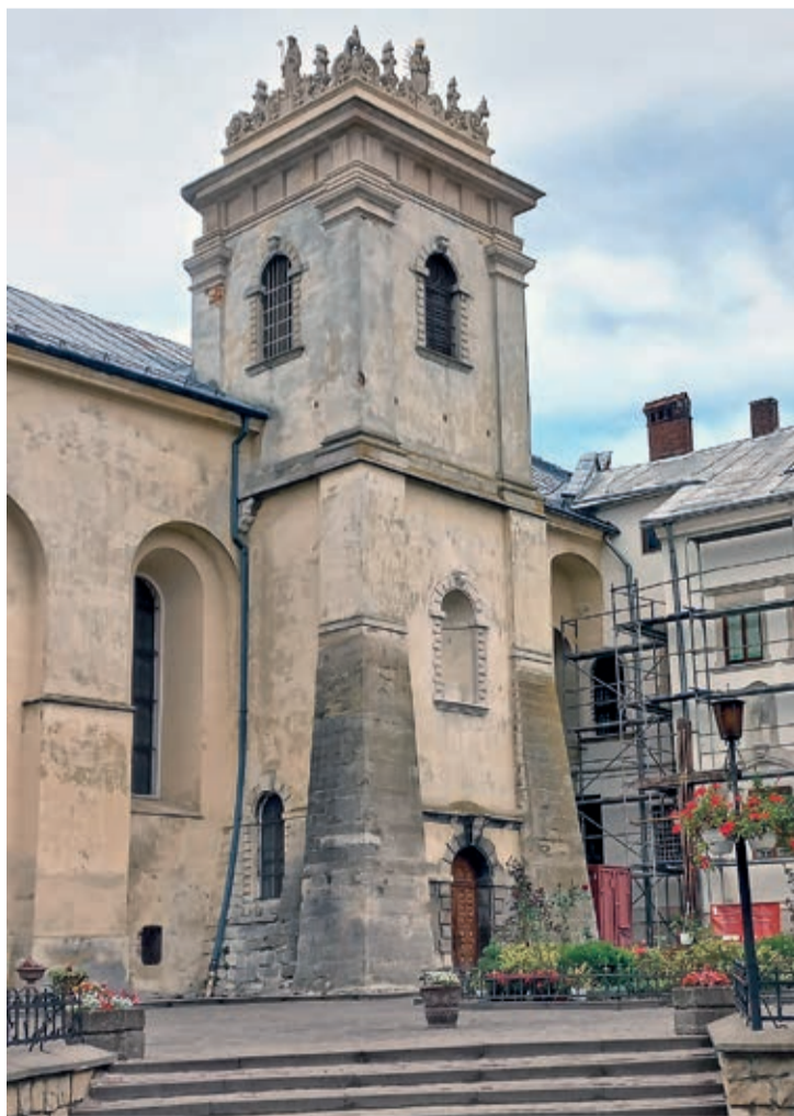
WIEŻA-DZWONNICA KLASZTORU BENEDYKTYNEK
