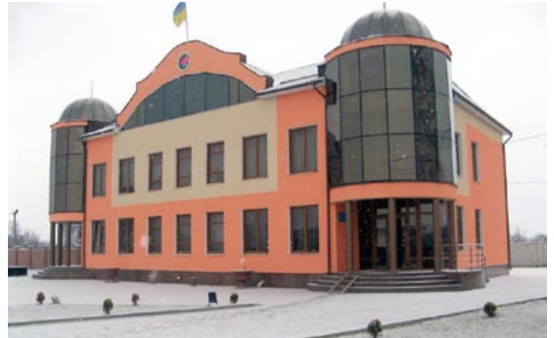
Budynek administracji w Boratynie
