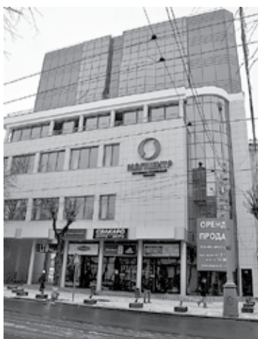
Budynek Magicentru, gdzie na przedostatnim piętrze mieści się Konsulat Generalny RP w Winnicy
