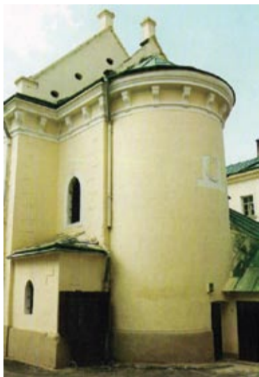
Dawny kościół ormiański p.w. Św. Krzyża przy ul. Zamarstynowskiej 9. Widok od południowego zachodu i apsyda od południowego wschodu
